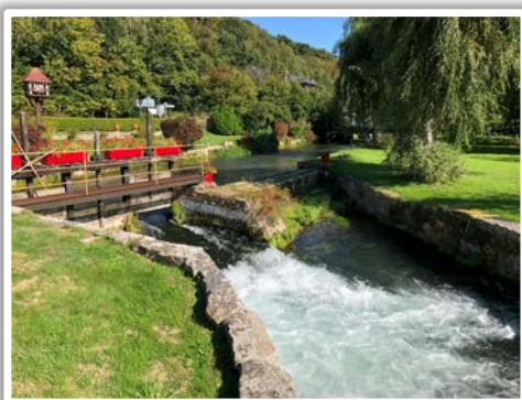
Figure 4 Vannage de la minoterie Bapaume
